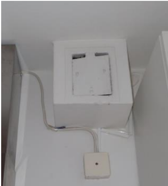
Stängt frånluftsdon (självdagsdon) i kök
