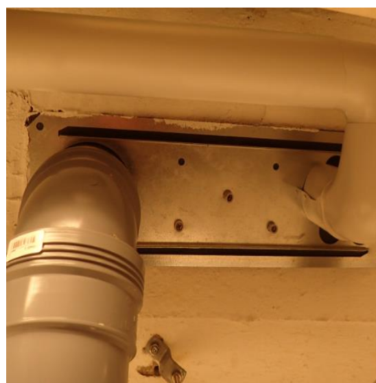
Nya genomföringar i tak (bjälklag). Vi konstaterade med rök att dessa var otäta.
