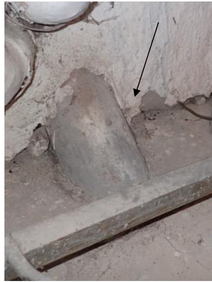
Luftläckage vid golvvinkel och genomföring för avloppsrör i cykelrum. Radonhalt 1270 Bq/m 3 .
