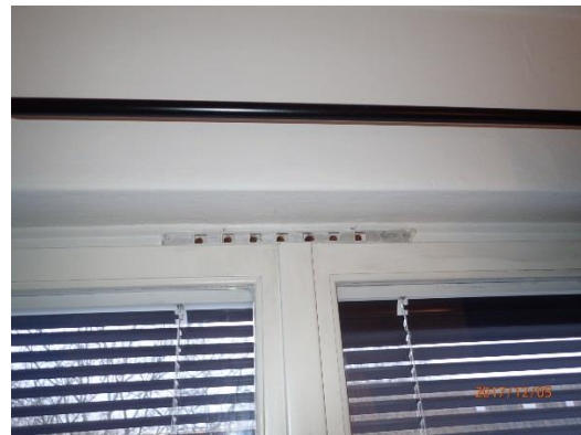
Friskluftsventiler i vardagsrum och sovrum. Liten hålarea i donen.
