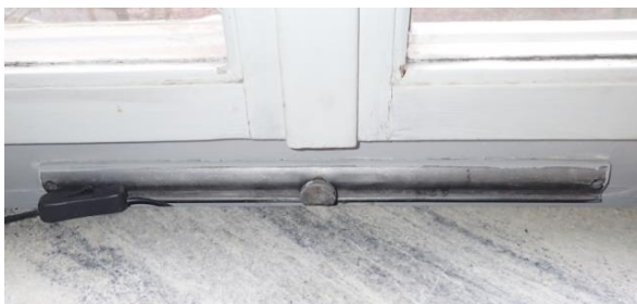
Blockerad friskluftsventil i sovrum
