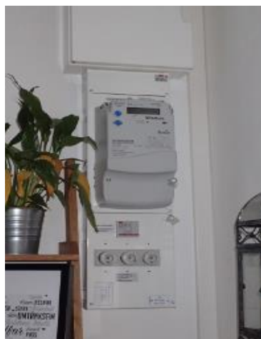
Elskåp. Inga tydliga luftläckage.
