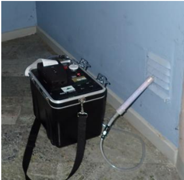
Ventil till outgrävt utrymme under trapp i källare på Bjulevägen 20-24. Radonhalt 623 Bq/m 3 .
