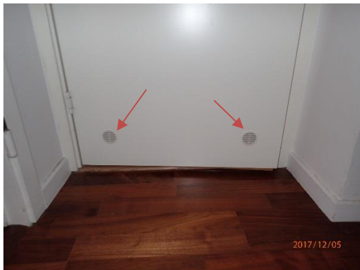
Överluft i badrumsdörr, liten hålarea.
