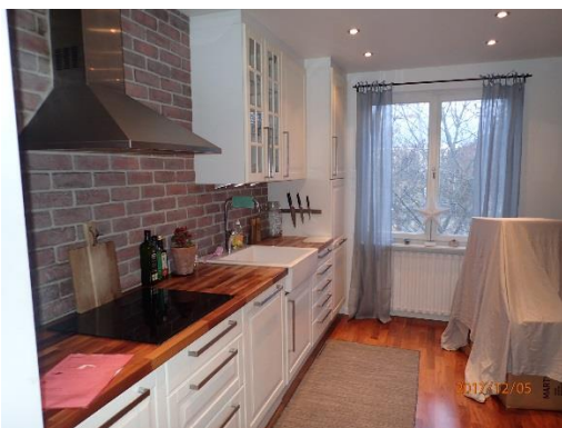
Nedpendlat tak i kök. Kolfilterfläkt, ej ansluten mot frånluftdonet.
