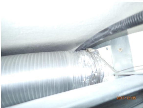
Ovanför det nedpendlade undertaket i köket syns denna spiroslang ansluten mot självdagskanalen. Frånluftflödet vid donet var mycket svagt.
