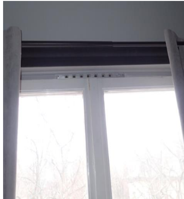
Friskluftsventil ovan fönster sovrum. Mycket liten hålarea.
