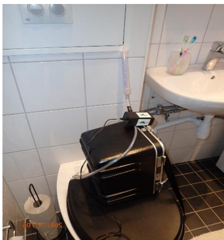
WC luftläckage bakom inklädnad.
